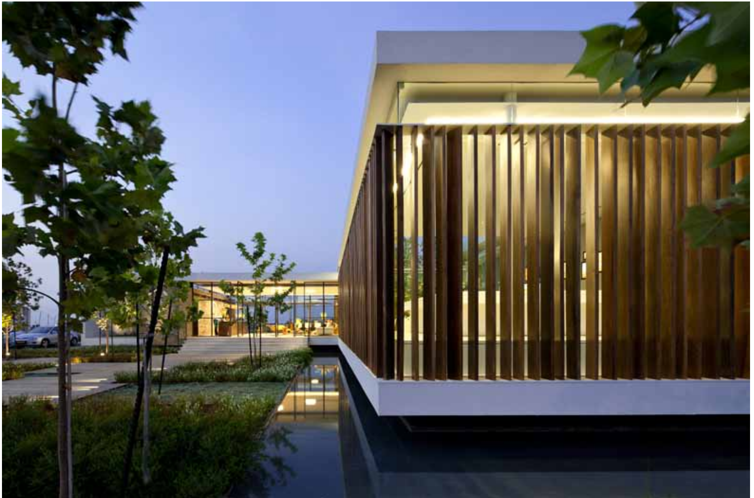
בשעות החשיכה: האופן בו מופץ האור דרך סרגלי העץ הופך את המבנה לפסל תאורה.
